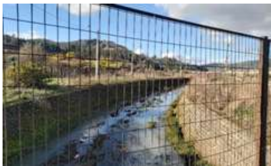
Figura 13: Encauzamiento del Estero Llahuallin, Padre Las Casas para habilitar terreno para el desarrollo de proyectos inmobiliarios. A pesar de estar el estero encauzado, en algunos sectores colindantes a él, la vegetación da cuenta de la presencia de agua generando nuevas áreas de humedales.
