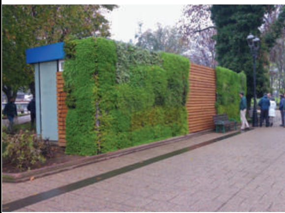
Fotografía: Muro verde en modernos baños públicos en la Plaza Dagoberto Godoy, Temuco. Municipalidad de Temuco.
